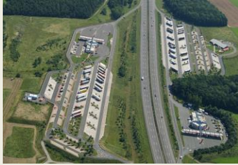
Autobahnraststätte (Quelle: BMVI, 2021)
